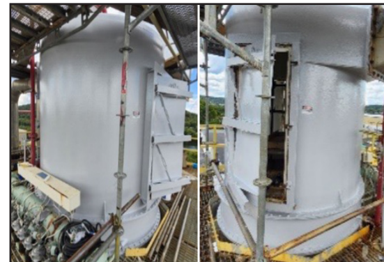
ARC CS2 appliqué comme couche de finition sur les réparations avec du CFW-CR.
